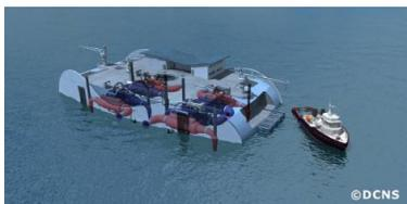
La filière d'énergie thermique des mers utilise la différence de température entre les eaux chaudes de surface et les eaux froides des profondeurs pour produire de l'électricité. Des développements technologiques complémentaires sont aujourd'hui nécessaires pour parvenir à moyen terme à produire en série des centrales ETM.
